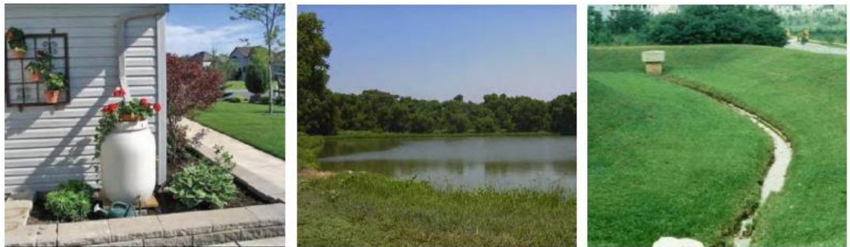
图 5.6.5.1 雨水罐、雨水湿塘、雨水干塘
