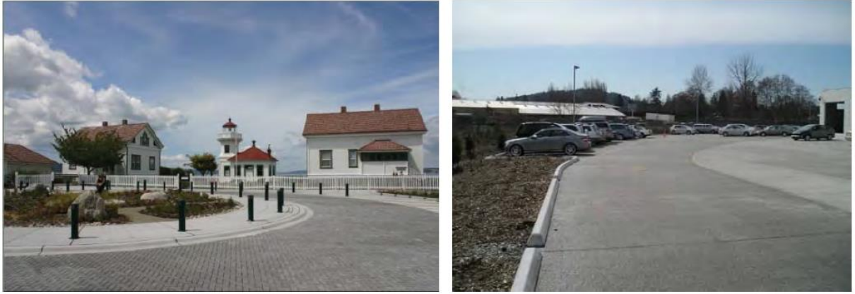
图 5.6.1-1 透水铺装和透水路面
