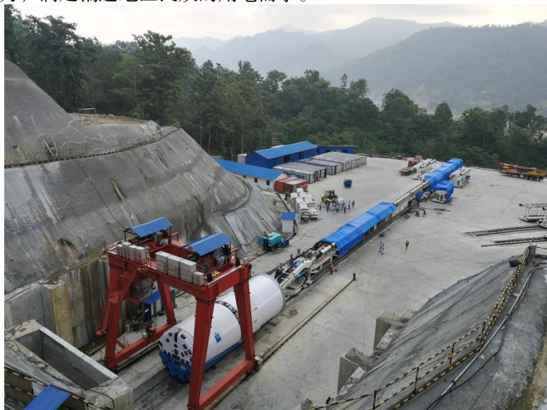
巴瑞巴贝引水项目双护盾隧道掘进机（TBM）进场组装现场
